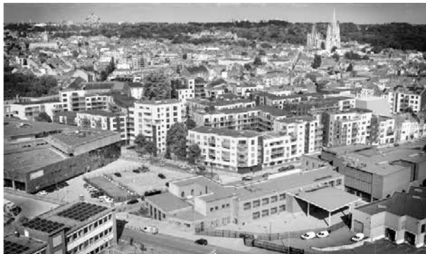
Figuur 8. GreenBizz aan de linkerzijde van de foto en Tivoli als bouwblok in het midden (BRUZZ, 2016)
